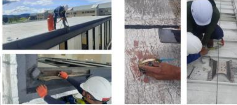
Mantenimiento Cubierta Metálica
