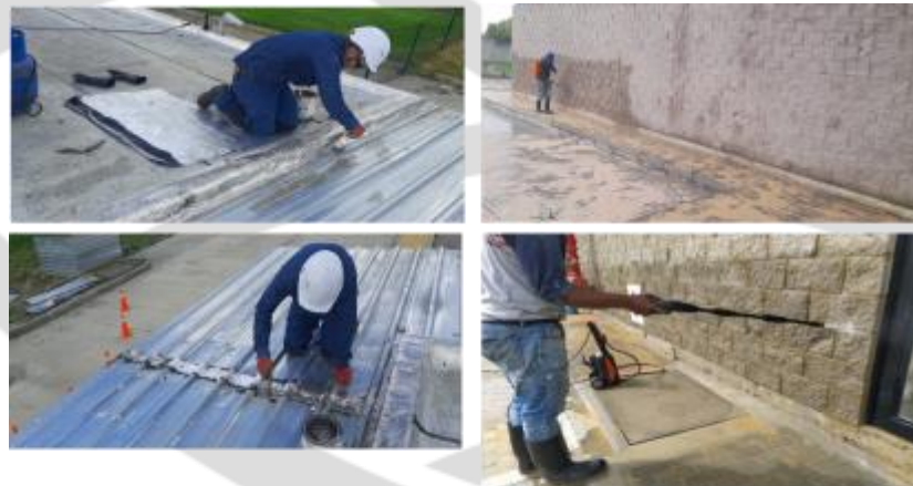
Mantenimiento Techo y Fachadas
