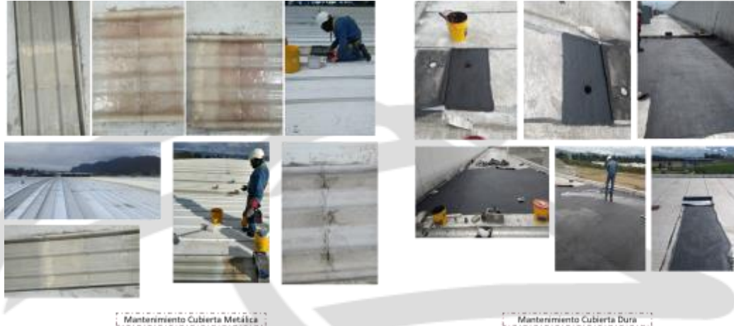
Mantenimiento Cubierta Metálica
