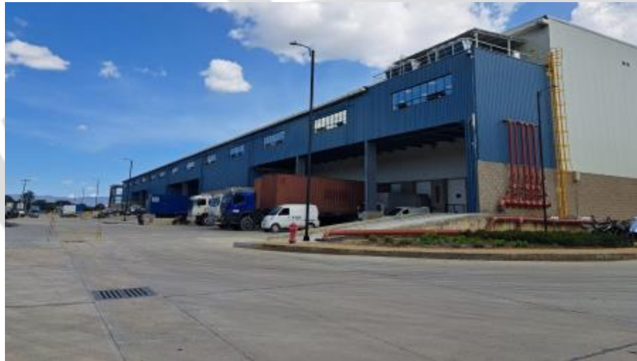
1.6. Avance de Obra Manzana 3-Etapa2
