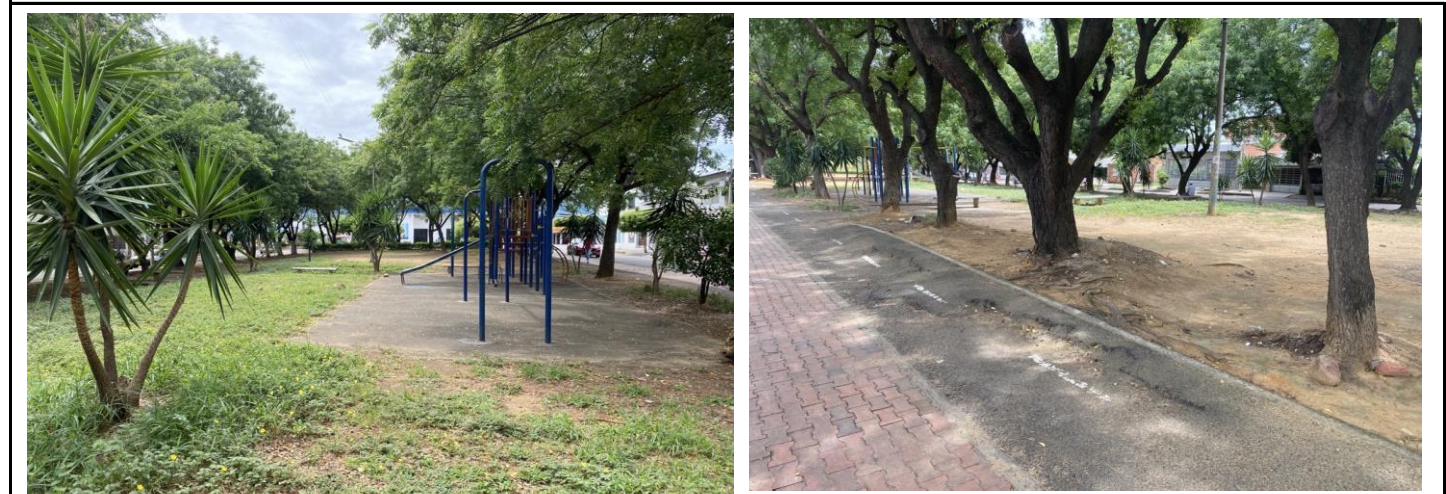
Mobiliario existente y afectaciones de andenes por raíces.
